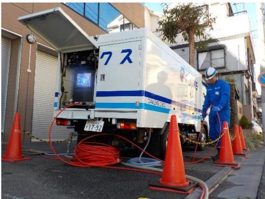
一般に使用されている 20 MPa (約 200kgf/cm<sup>2</sup>) クラスの機械では洗浄力不足です。フジクス開発の洗浄車であれば、**洗浄に必要な十分な圧力も、多くの汚れを搬出するために必要な水量も確保**できます。また超高層マンションでは作業に伴う下水臭気対策も必要なこともあります。
