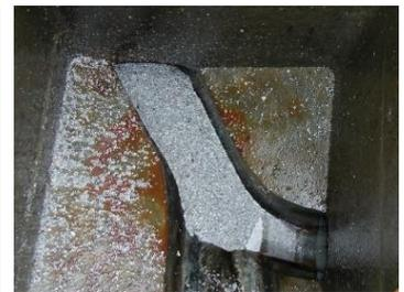
（ディスポーザー排水管内部）卵の殻などが排出されずに堆積
