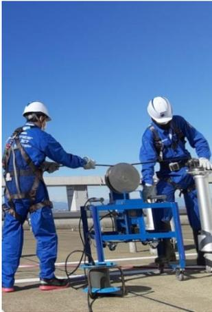
100m を超える配管を一気に洗浄するには、適正圧力と流量、噴射ノズルの一定速度進行、そして洗浄に最適な治具開発等の高度な技術が求められます。
